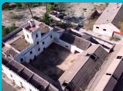
REHABILITACIÓN DEL PALACETE DE LA CIERVA (LORQUÍ)
